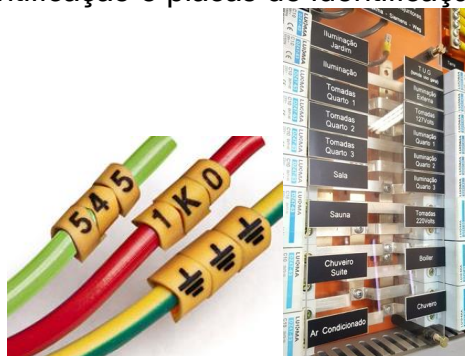
Figura 2: Anilha identificação e placas de identificação dos Circuitos
