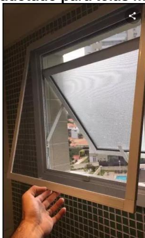
Figura 4: Ilustração mecanismo adotado para telas milimetradas em janelas maxim-ar.
